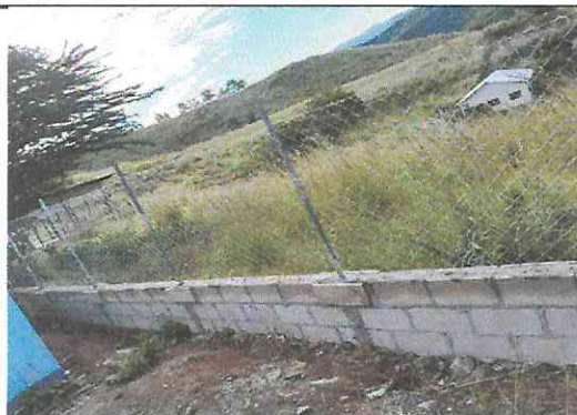
Foto 5: Reconstrucción de muro perimetral que comprende su función de cimiento, levantado de 60 cms de block, colocación de hilada de U fundida y 1.50 mts de malla fundida en U en la parte de abajo, con tubo galvanizado de 1 pulgada horizontal en la parte de arriba y sus respectivos tapones en los tuvos galvanizados
