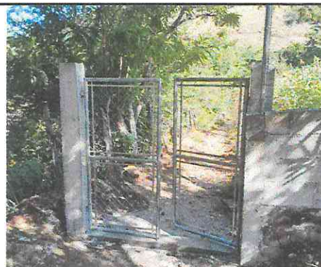
Foto 4: Reconstrucción de portón para ingreso del establecimiento de 1.10 metros por 2.00 metros
