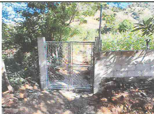
Foto 3: Reconstrucción de dos columnas de 20X20 X 250 de alto
